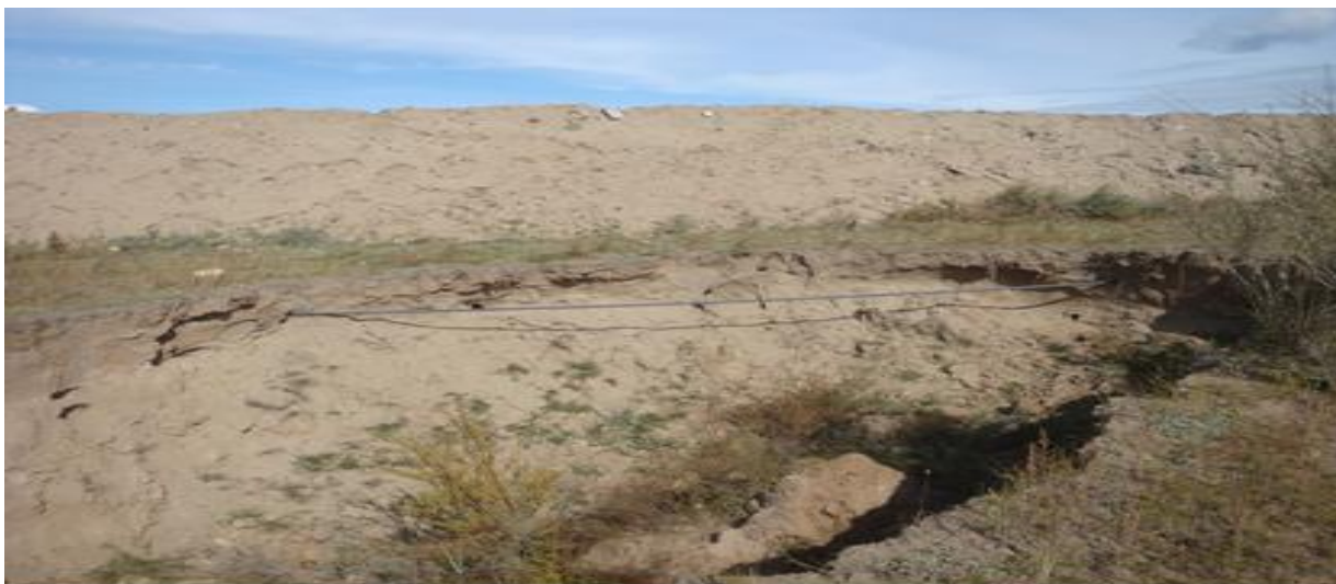
Рис. 2.7. Рост промоины (отвершка), верхушка направлена к автодороге, размыв кабеля связи (Чаданский участок)
