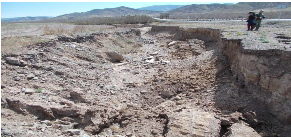
Рис. 2.9. Процессы оврагообразования на Уюкском участке (участок федеральной трассы Р-257 в районе с. Уюк Пий-Хемского района)
